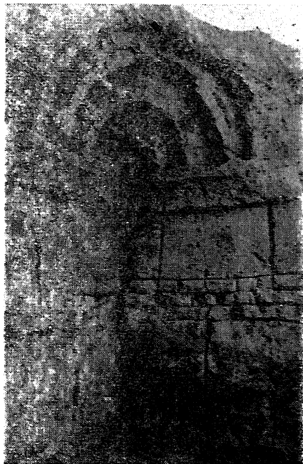
Рис. 6. Фрагмент стены в помещении с куполом.
